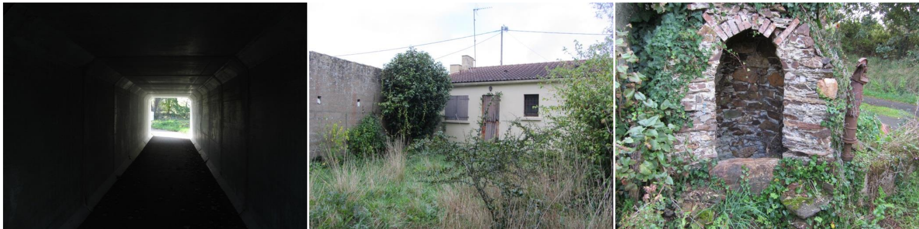
De gauche à droite : pont cadre sous la RD32 – maison détruite au sud de La Petite Bardinière – puits en pierre supprimé
